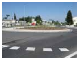
Sur la RD7, à l'entrée du pôle, un rond-point tout neuf et sécurisé
