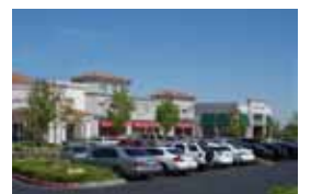
Projet de la Palmeraie, tel qu'il sera à la fin de l'année, une fois achevé (photo montage)
